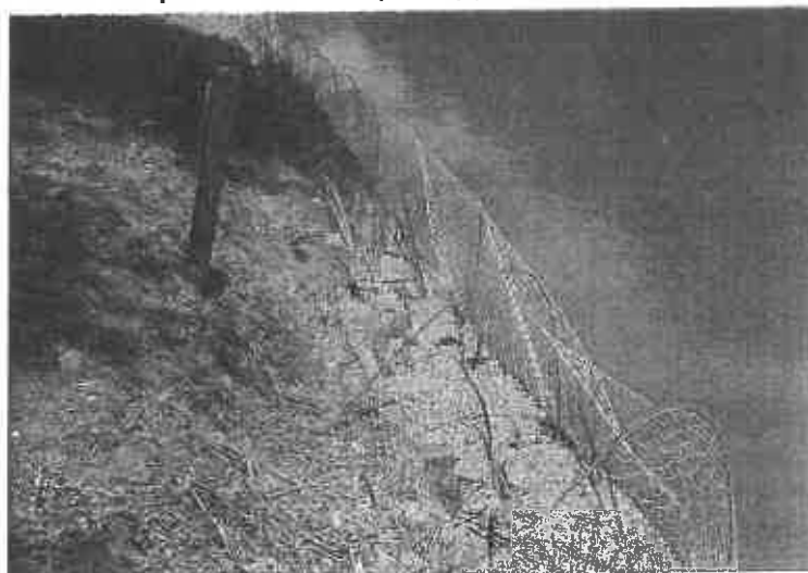
Risberme basse à héliophytes étroite (0,5 m de large), juste après sa mise en œuvre.
